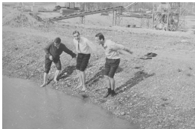
De G. à Dr. : Jean Michel DORE (ECL66), Pierre COMVOPOULOS et Philippe ROCHEFORT sur le chantier d'Ecully
